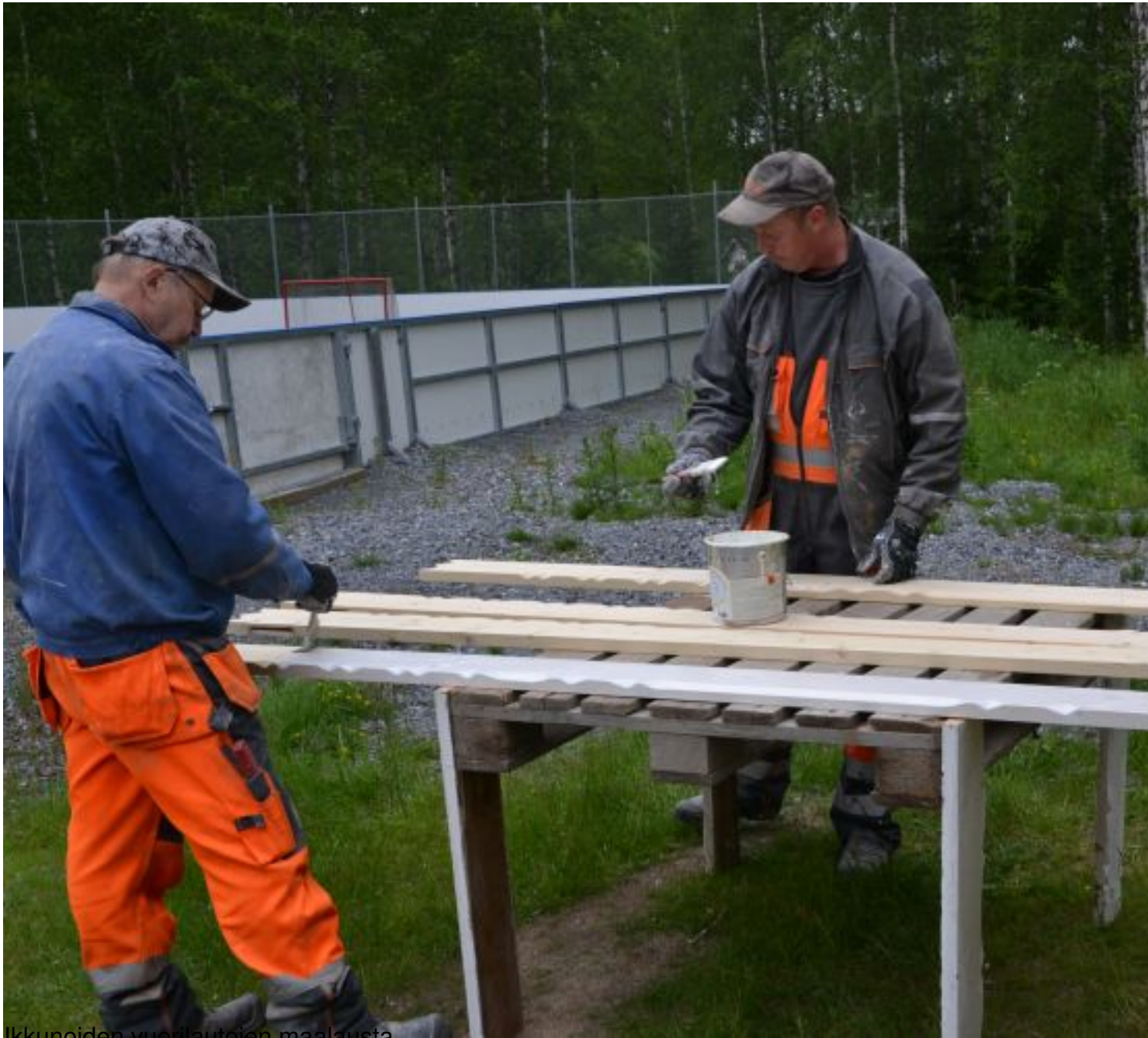
Ikkunoiden vuorautojen maalausta.
